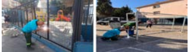
Saygı Mahallesi Nuri Öz İlkokulu Raylı Giriş Kapısı Onarım İşi
