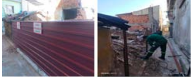
Ballıkuyu Mahallesi 5300 Sokak No: 3 Adresinde Çökmüş Metruk Yapı Çevresine Karkaslı Trapez Sac Montaj İşi
