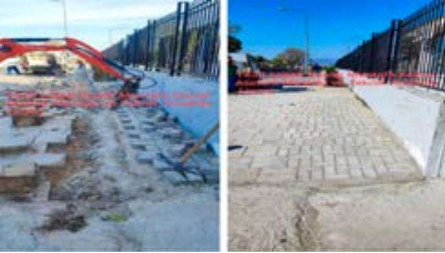
Çınarlı Mahallesi Bölge Adliye Mahkemesi Çevre Düzenlemesi İşi -- 640 m2
